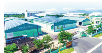
Nhà máy chế biến Nha đam tại KCN Thành Hải Aloe vera processing factory in Thanh Hải industrial zone
